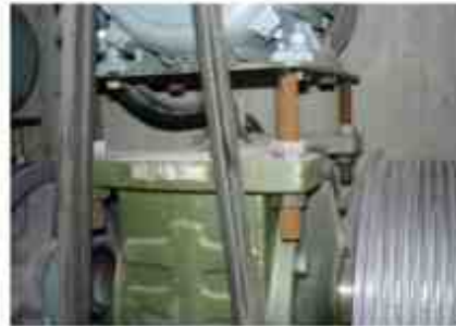
그림 49 전동기 프레임 고정 볼트 산화
