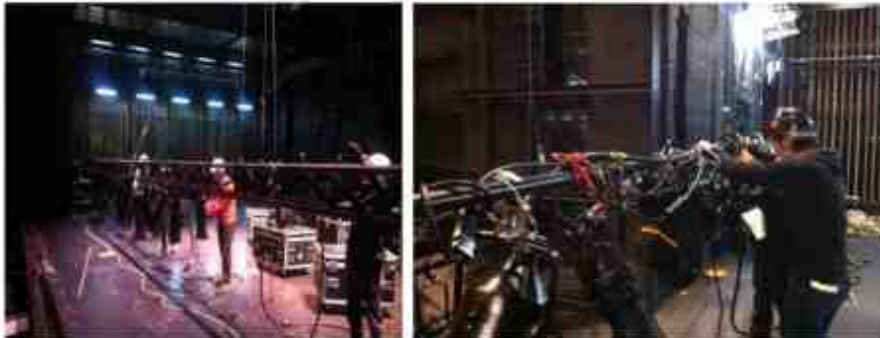
무대상부(Electric Batten)에 조명을 설치하는 조명 크루(Electrician)
